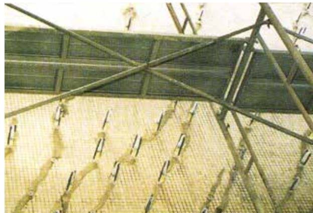
外壁タイルひび割れ補修
