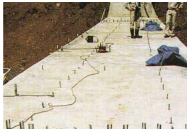
砂防ダムひび割れ補修
