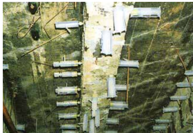
梁ひび割れ補修
