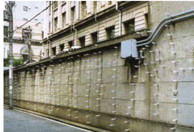
外壁ひび割れ補修
