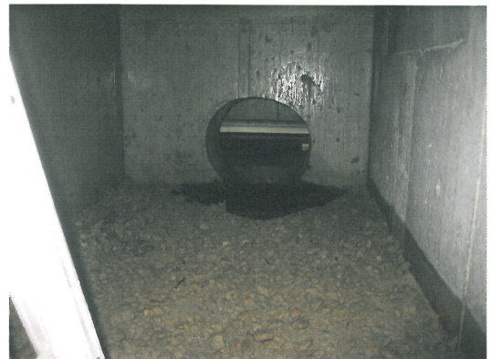
1階床下 点検（異常なし）
