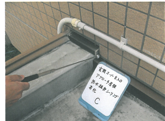
玄関ホール屋上 C
