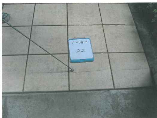
1 階渡り廊下 1 階渡り廊下
