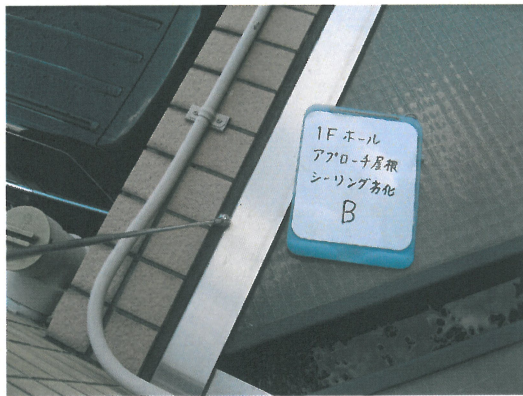
玄関ホール渡り廊下屋根 B
