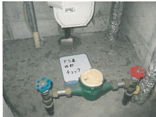
P S 扉内部 点検（異常なし）
