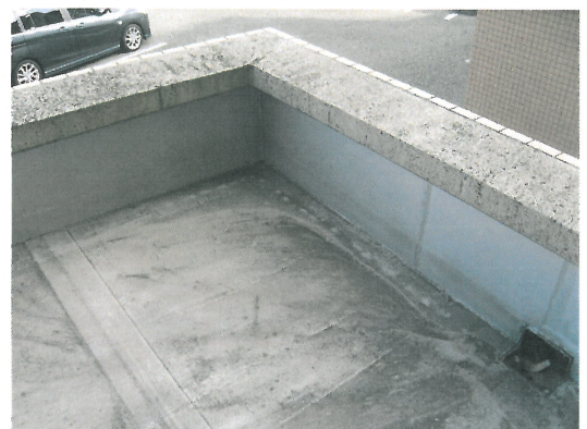
E V機械室屋上 点検（異常なし）
