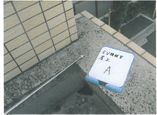
E V機械室屋上 A
