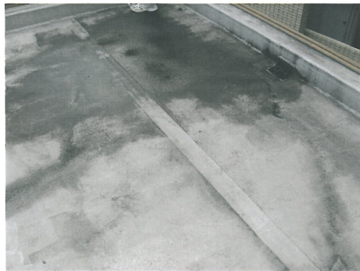
玄関ホール屋上 点検（異常なし）
