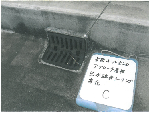
玄関ホール屋上
