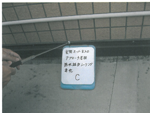
玄関ホール屋上 C
