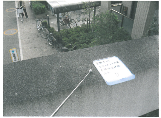
玄関ホール屋上
