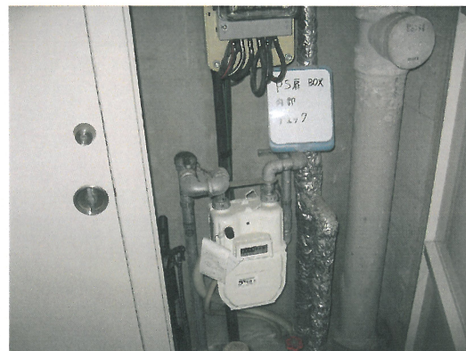
P S 扉内部 点検（異常なし）
