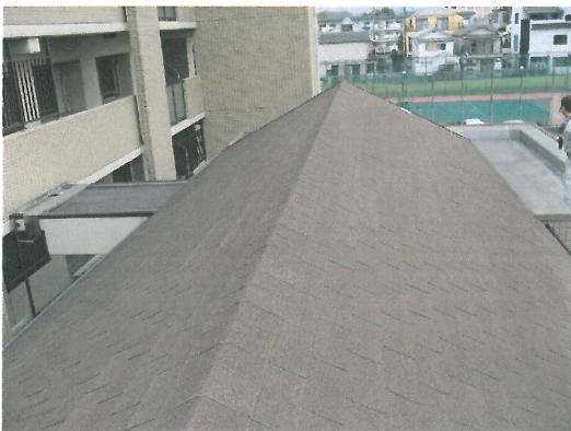
玄関ホール屋上屋根 点検（異常なし）
