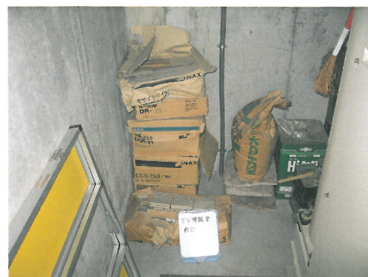
E V 機械室 室値井点検（異常なし）
