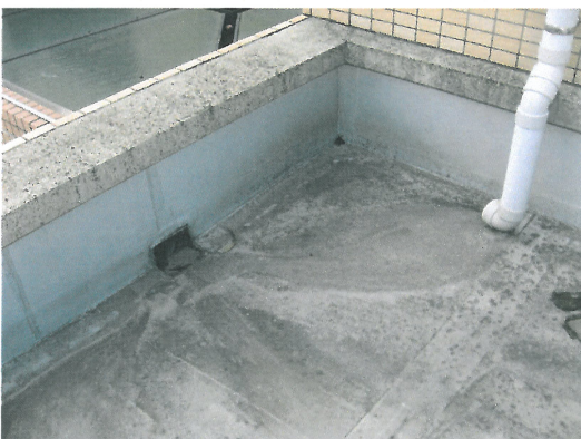
E V機械室屋上 点検（異常なし）
