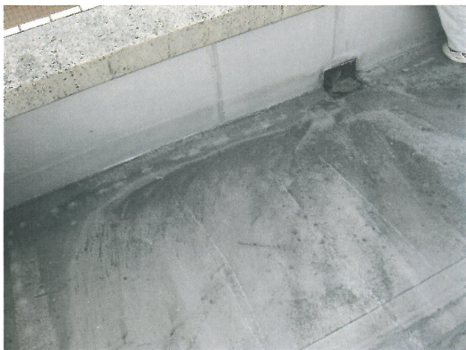
玄関ホール屋上 点検（異常なし）
